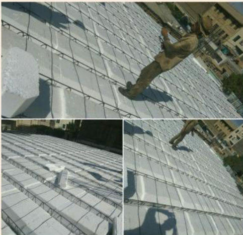
پروژه اسکلت بتنی با سقف تام - دهانه ۱۰ متر
