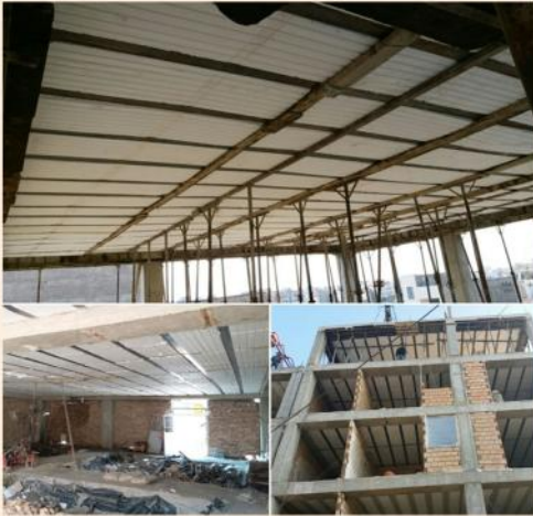
پروژه اسکلت بتنی با سقف تام - دهانه ۱۰٫۷۰ متر
