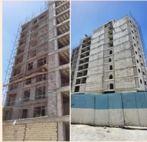
پروژه اسکلت بتنی با سقف تام - دهانه ۱۲ متر
