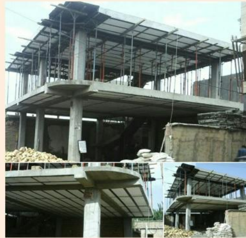
پروژه اسکلت بتنی با سقف تام - دهانه ۱۰.۵۰ متر
