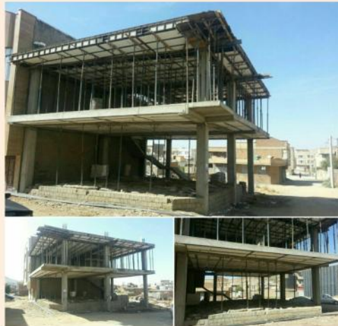
پروژه اسکلت بتنی با سقف تام - دهانه ۱۱.۲ متر
