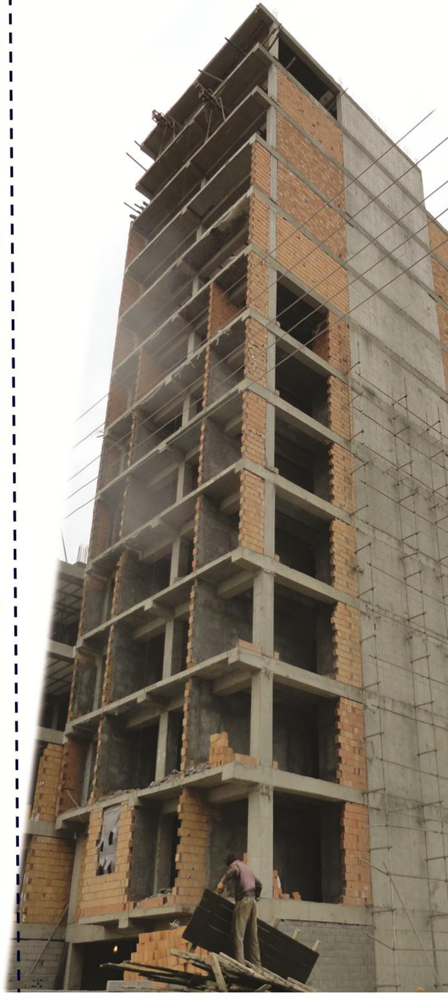
طراحی اولیه با سیستم اسکلت و سقف تیرچه بتنی - قاب و دیوار پرشی
